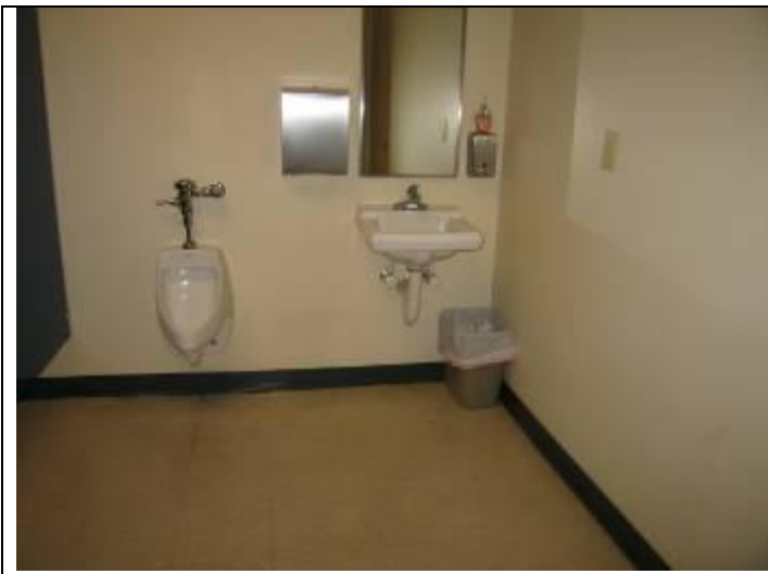
31. ADA toilet entry
