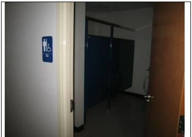
30. ADA toilet entry
